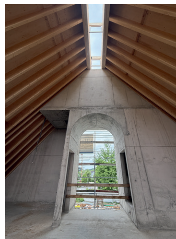
Baustellenupdate: August Juli 26'
